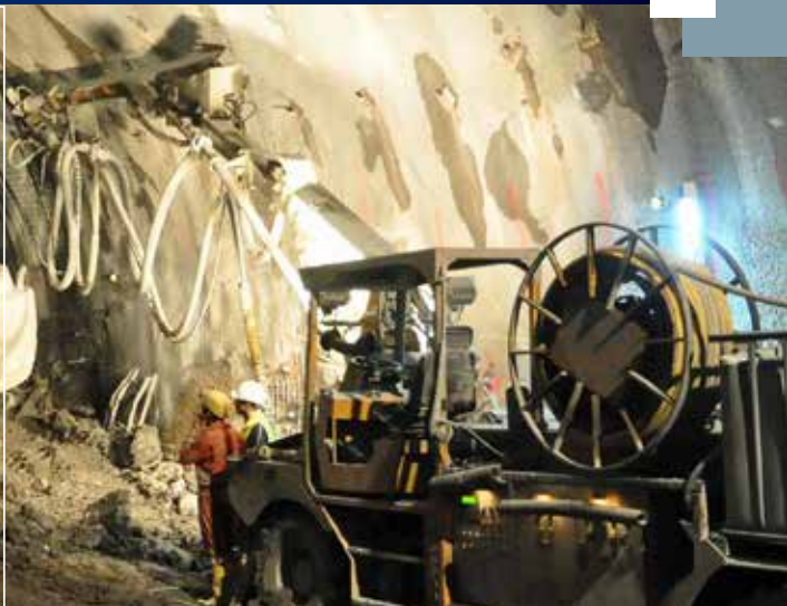
Tunnel Waidhofen/Ybbs, Österreich
