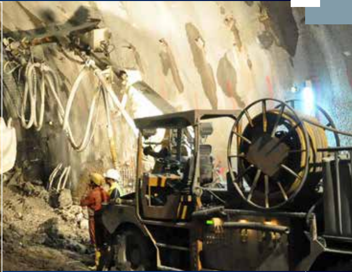
Tunnel Waidhofen/Ybbs, Österreich
